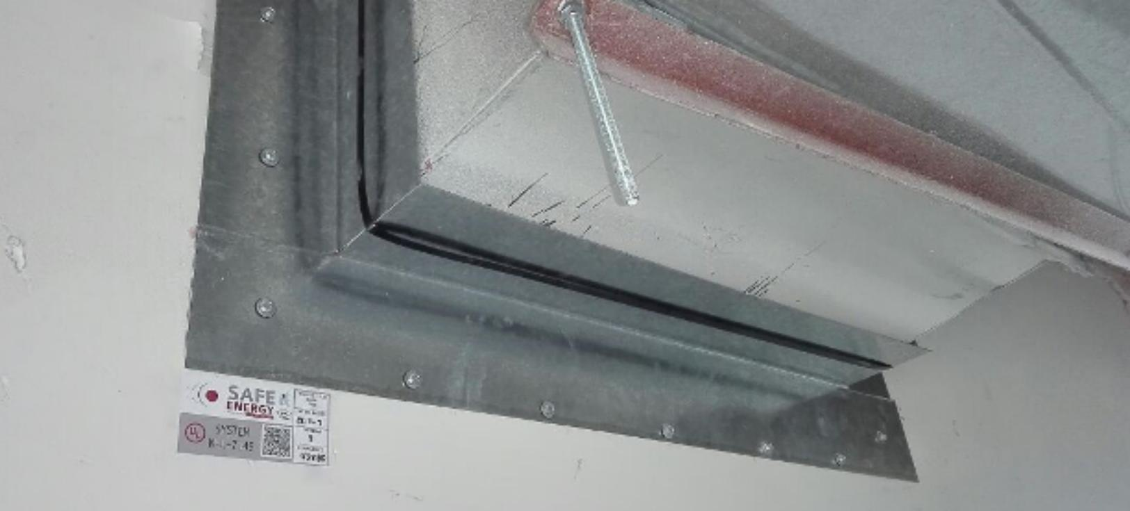
**Sistema cortafuego para pasadas de ductos de aire acondicionado con 120 min de protección**
